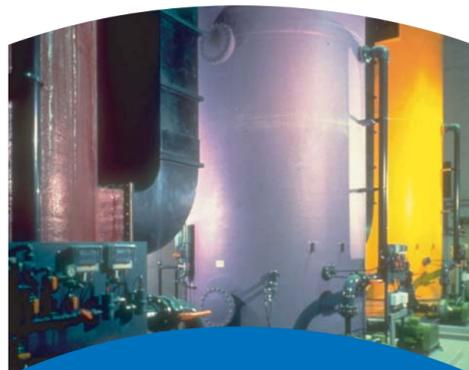
OXYREG® est une technique originale permettant d'ajuster instantanément et précisément la concentration du chlore injecté dans les tours de lavage. Elle s'appuie sur un système d'analyse optique (brevet Veolia Water Solutions & Technologies et SECOMAM) qui contrôle en continu la teneur en chlore des eaux de lavage. La quantité globale de réactifs utilisée s'en retrouve réduite et les rendements épuratoires accrus.
