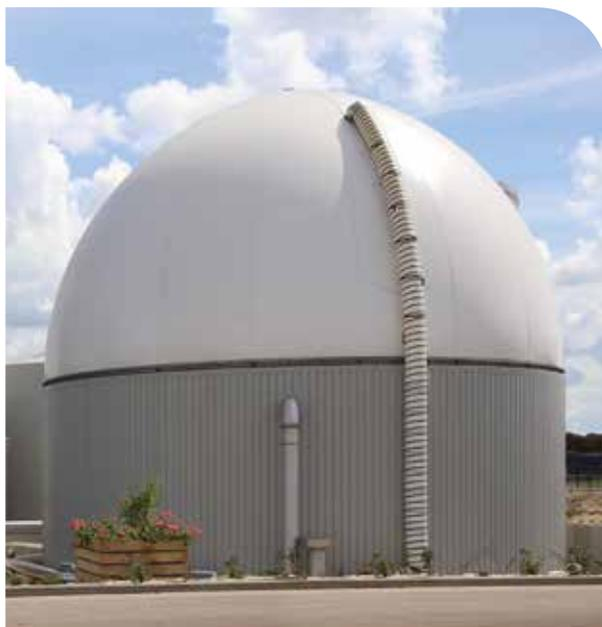
On s'en sert pour alimenter un moteur de cogénération et produire ainsi de l'électricité et de la chaleur. Il peut également être épuré pour obtenir du **biométhane** qui sera injecté dans le réseau de gaz naturel ou utilisé comme carburant pour les véhicules roulant au GNV (Gaz Naturel Véhicule).
