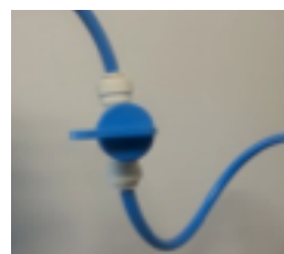
➤ Vanne arrivée eau
